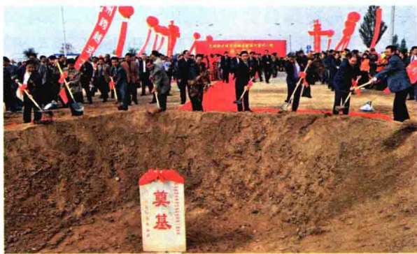
◆◆ 兰州新区城市基础设施建设暨纬一路开工奠基仪式 (兰州市档案局供图)
