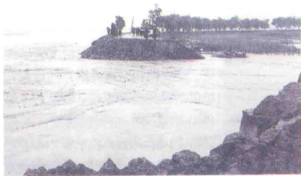
黄河洪水造成决堤
