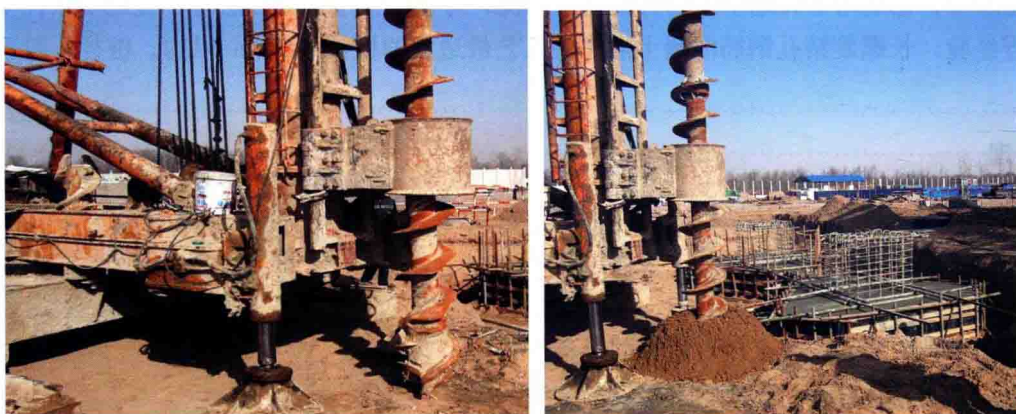
图 1-5-2 桩机钻头对准桩位和钻孔
