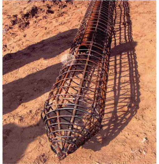
图 1-5-3 钢筋笼制作实物图
