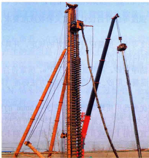
图 1-5-4 吊车吊起钢筋笼
