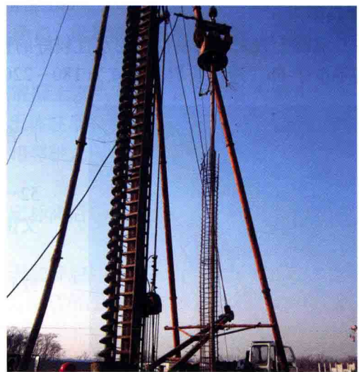
图 1-5-5 钢筋笼在振动锤的作用下插入桩身混凝土中
