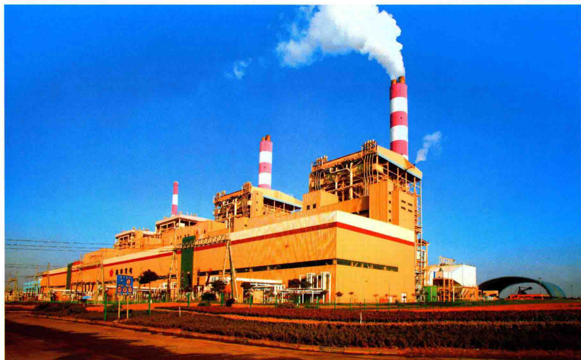
二期 4×600MW 厂房
