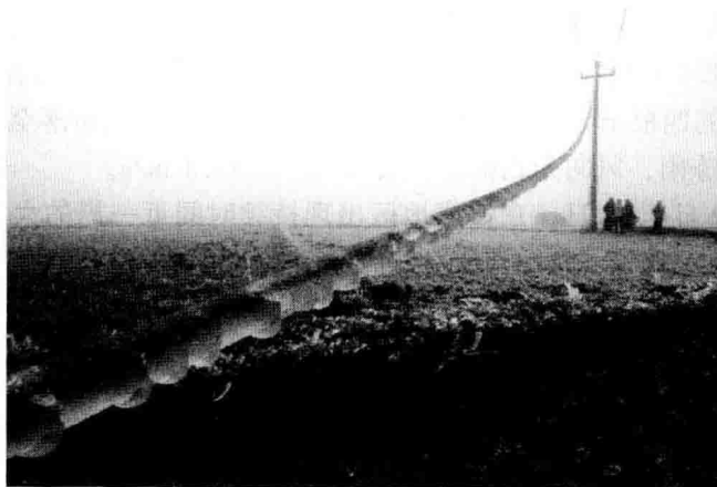
图1.2 输电线路覆冰断线
