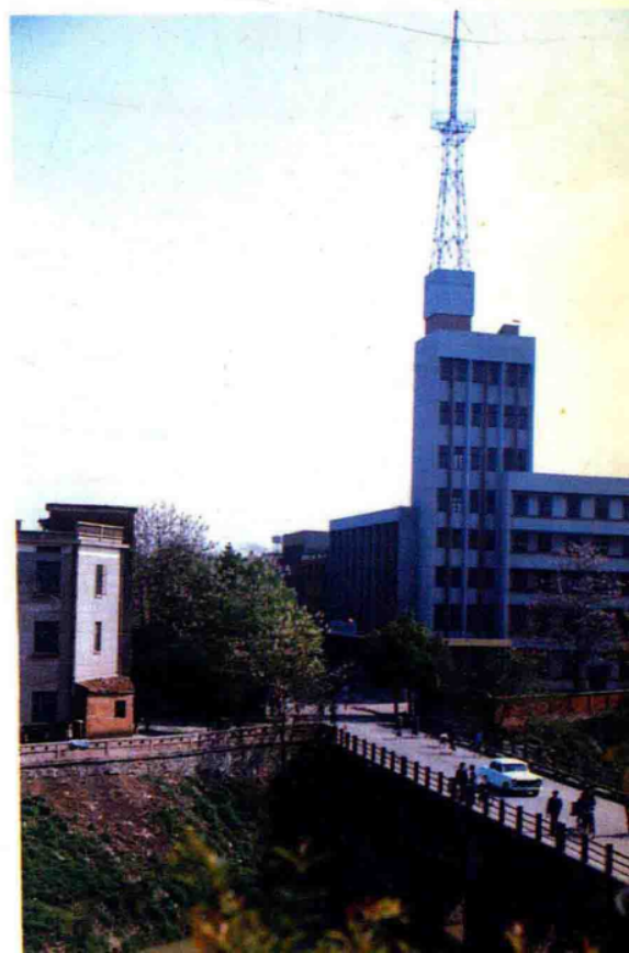
广播电视大楼
