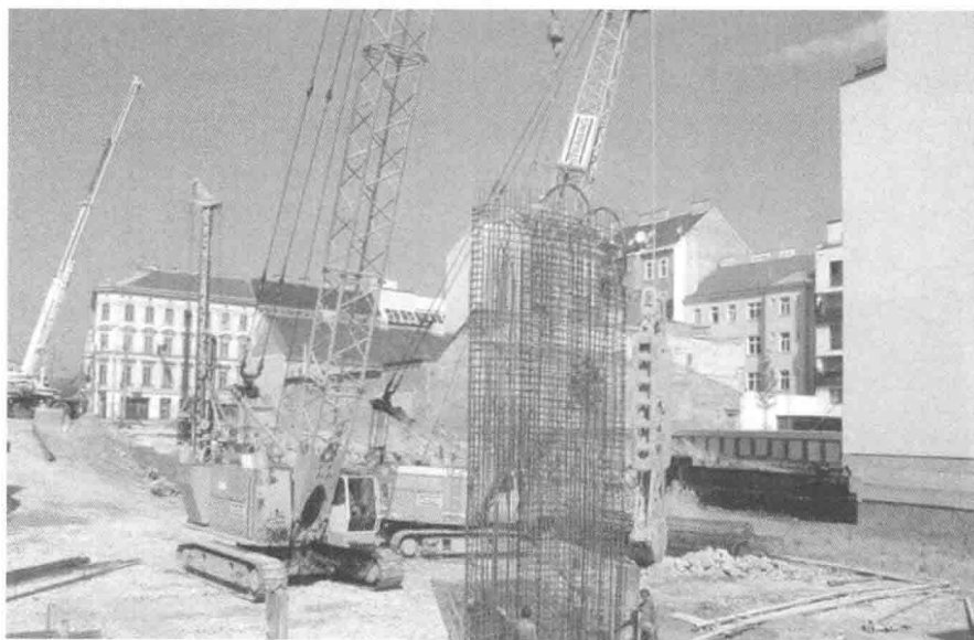
图 1-6 能源连续墙现场施工图
