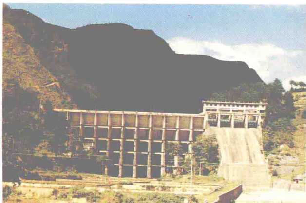
全区最早建成的中型水库——东安县金江水库钢筋混凝土平板坝。
