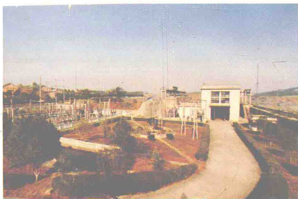
东安县湘江电站厂房 和升压站
