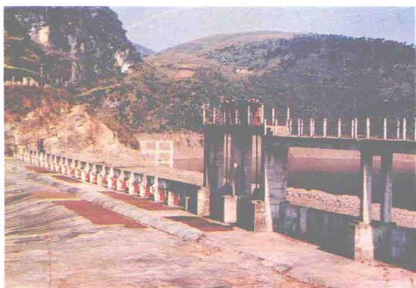
东安县松江中型水库
