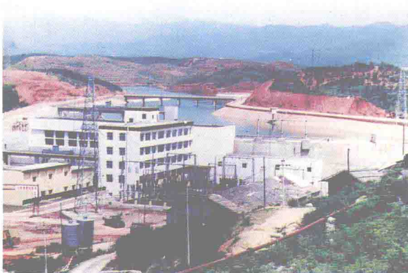
引进奥地利发电设备的永州市 南津渡电站厂房和前池
