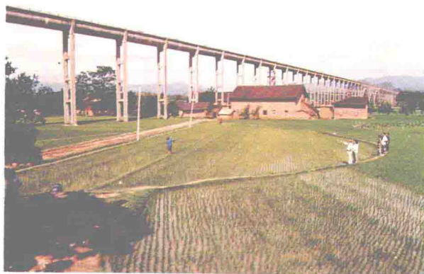
过水流量 6.88 个。 槽，长 980 米，高 29 米， 涔天河水库灌区西河渡
