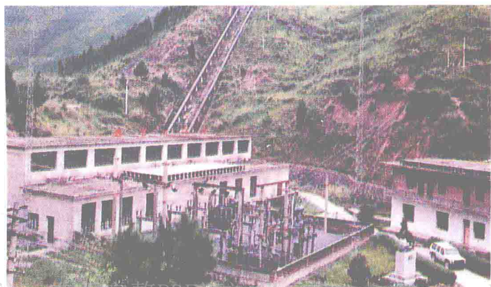
位于宁远县九嶷山下的高水头 骨干电站——九嶷山电站
