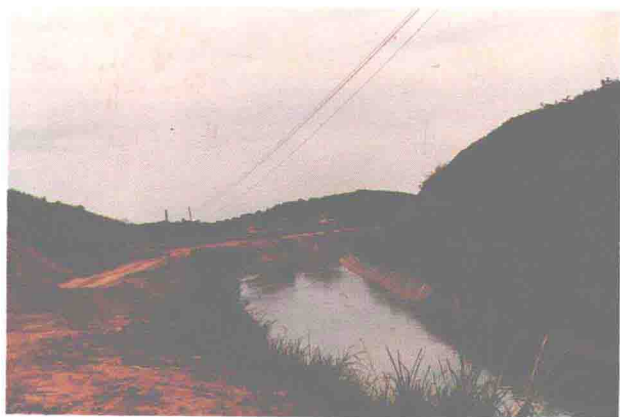
区渠道——双牌水库右干渠 全区灌溉 33 万亩农田的最大灌
