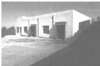
图 1-5 生活管理区——锅炉房
