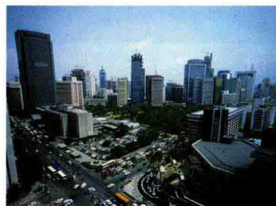
图 1-11 钢筋水泥建筑
