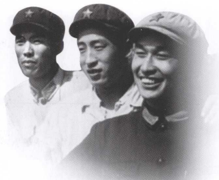
台山·工程兵安装营三大施工员
