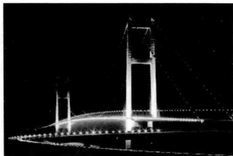
(b) 润扬大桥南汊桥
