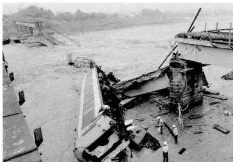
(a) 2010年8月19日 宝成铁路石亭江铁路大桥垮塌
