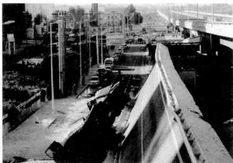
(d) 2012年8月24日 哈尔滨阳明滩大桥引桥发生坍塌
