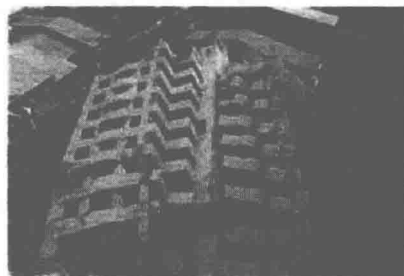
图 1.2 平面不规则结构破坏
