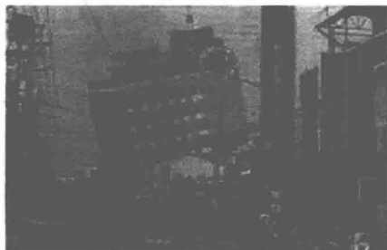
图 1.1 竖向不规则结构破坏
