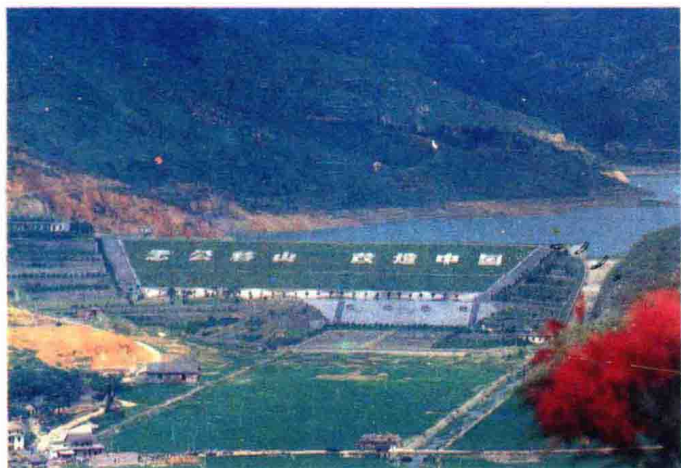
△桂阳县莲塘水库
