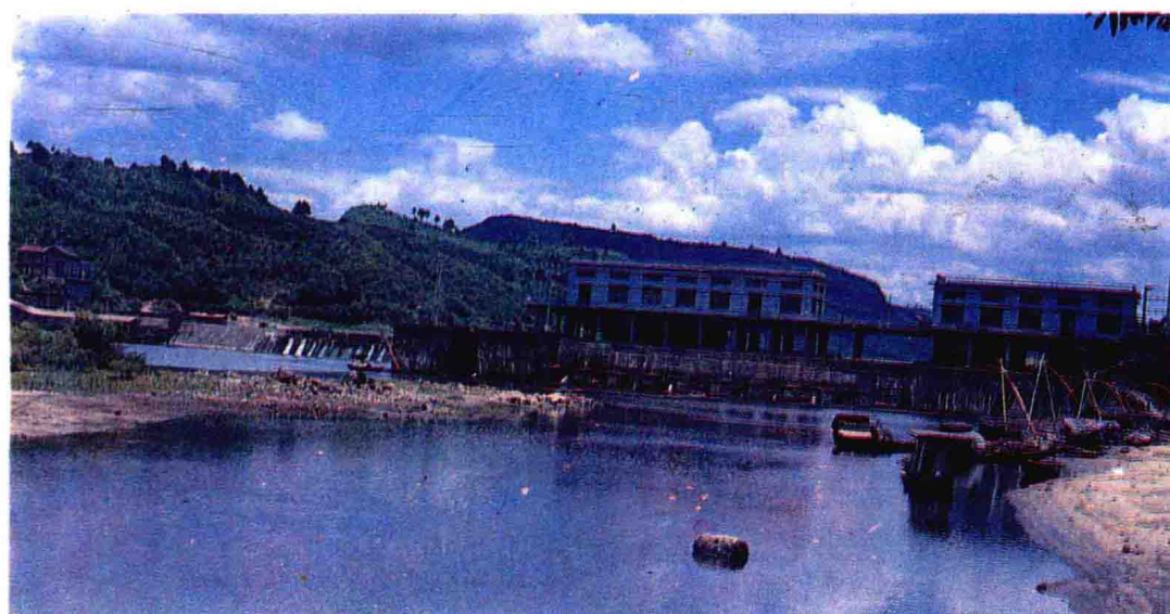
◁永兴县便江水 泵站、电站
