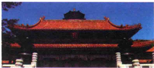
图1-12 黄色琉璃瓦屋顶
