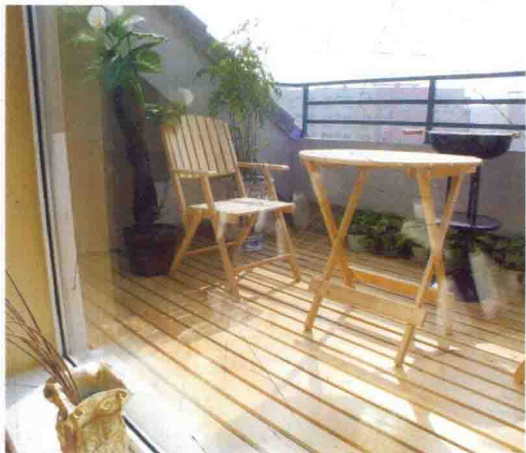
◆开放式的阳台采用防腐木铺装，延长阳台的使用寿命。
