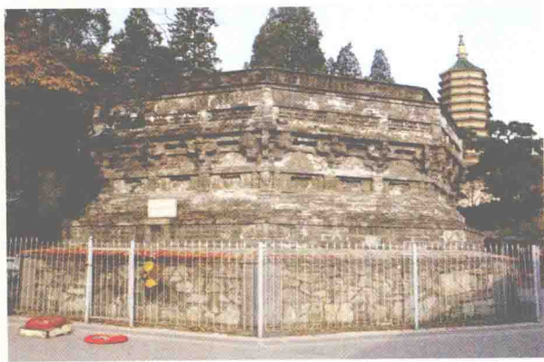
▲ 八大处招仙塔（辽塔）塔基
