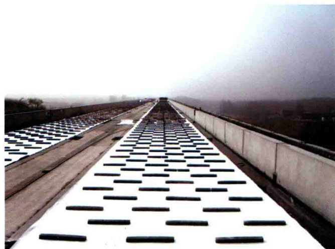
滑动层施工完毕
