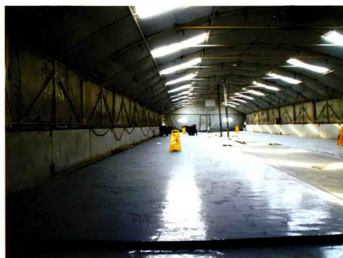
防水层冬季施工
