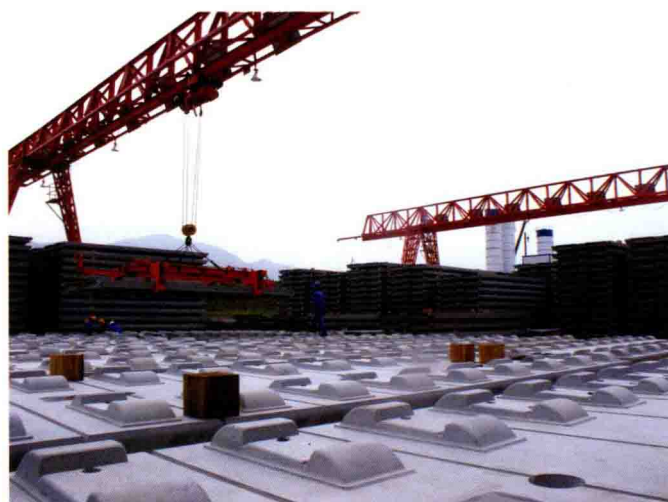
CRTS II 型无砟轨道板存板
