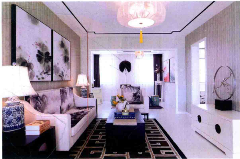
石膏板吊顶勾黑缝
