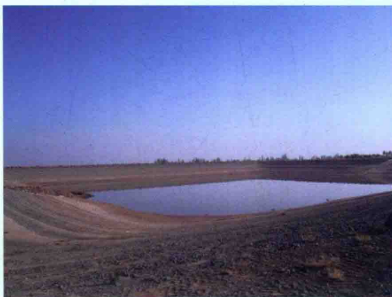
扬黄水调蓄水池
