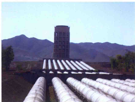
扬黄工程输水管道
