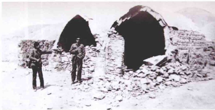
1982年海原5.5级地震，造成公路边长达180m的滑坡，土坯拱窑被破坏
