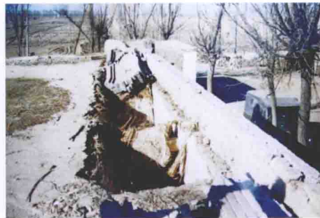
1988年灵武5.5级地震，出现喷砂冒水（左）；女儿墙砸塌房顶（右）
