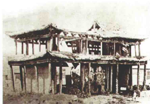
1920年海原8.5级地震，固原城墙崩坏，前提督署赏门塌坏，墙倒架在
