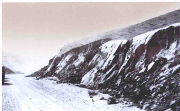
1982年海原5.5级地震，造成公路边长达180m的滑坡，土坯拱窑被破坏
