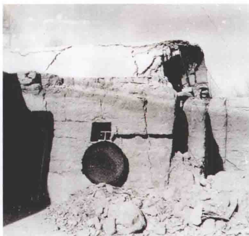
1970年西吉5.5级地震，房屋窑洞遭受破坏
