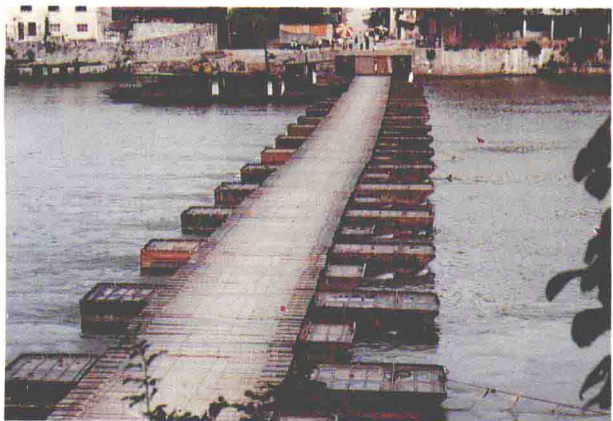
永州霞客渡浮橋
