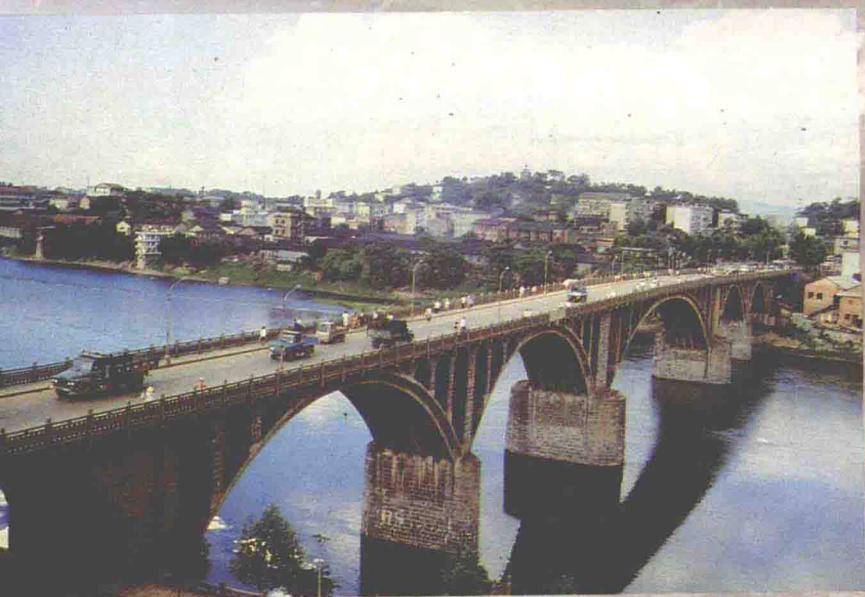
橫跨瀟水的零陵東風大橋
