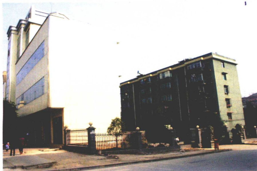
座落于岑巩县 新兴开发区振兴大 道 46 号的检察干警 生活小区
