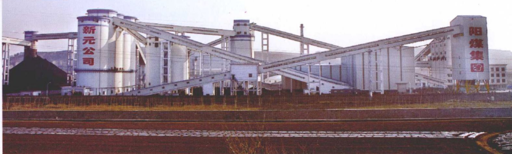
阳煤集团新元煤业公司洗煤厂
