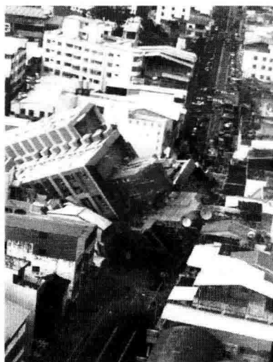
图 1-5 我国台湾集集地震中部分避难据点倒塌
