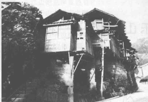
“悬吊吊”的阁楼
