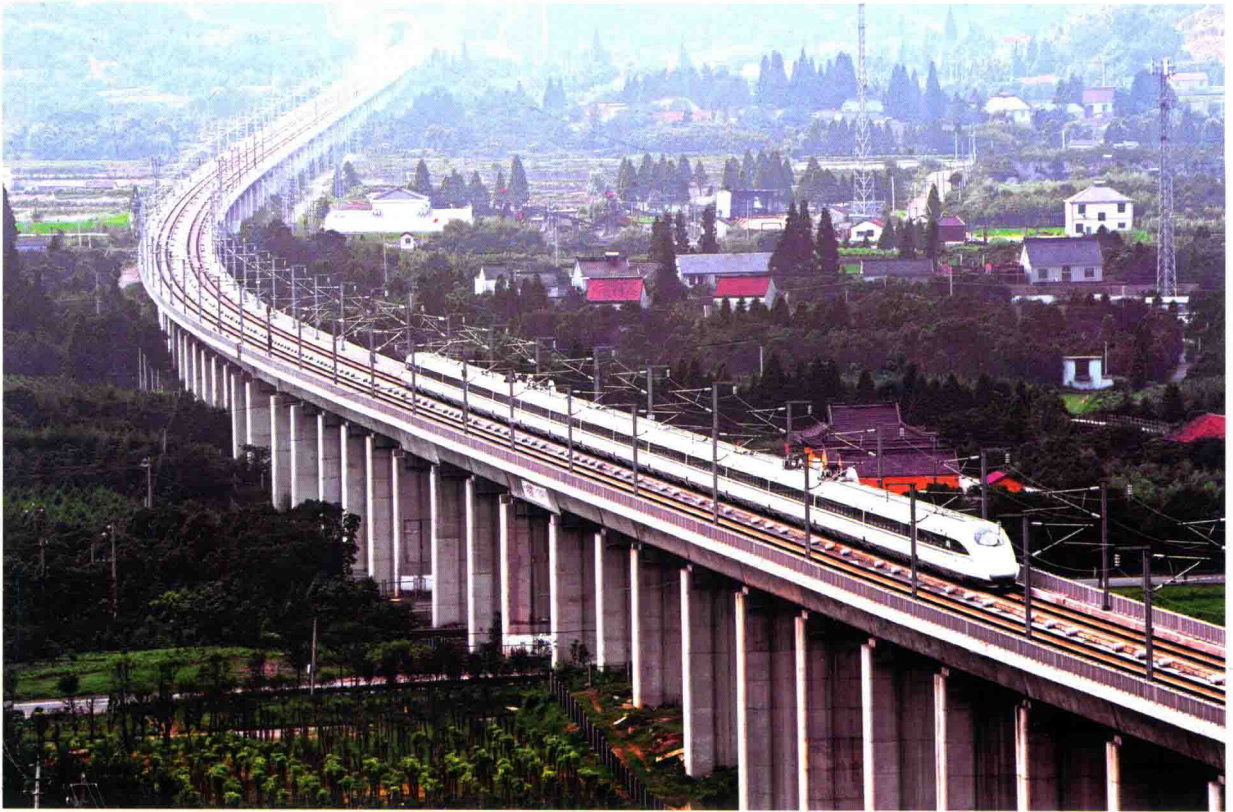
宁杭高铁工程全长 248 公里，其中湖州段 77.5 公里，设长兴、湖州和德清三个站。
